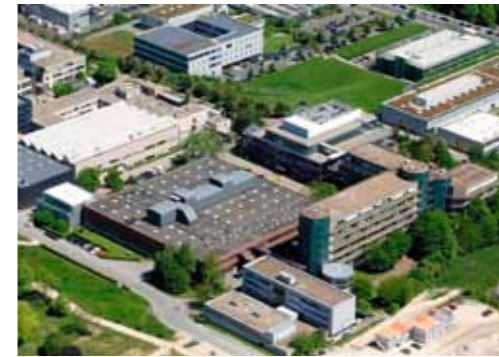
Links: Hallenbereich und Bürotrakt von WZL und ADITEC mit einer Gesamtfläche von über 10.000 m 2
